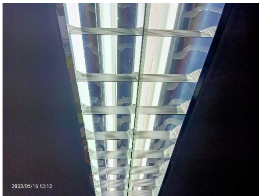
โคมไฟ แบบสะท้อนแสงและ หลอดไฟ LED
