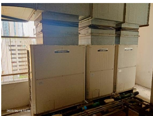
เครื่องปรับอากาศแบบ VRF
