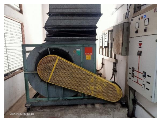
พัดลมอัดอากาศที่ชั้นหลังคา
