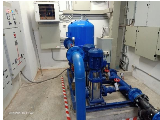
บูสเตอร์ปั๊มชั้นดาดฟ้า
