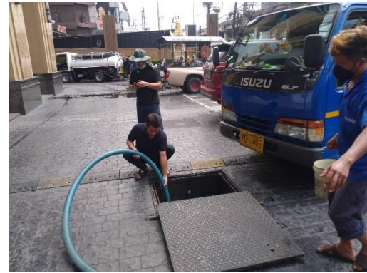
สูบลูกอมระบบบำบัดน้ำเสีย
